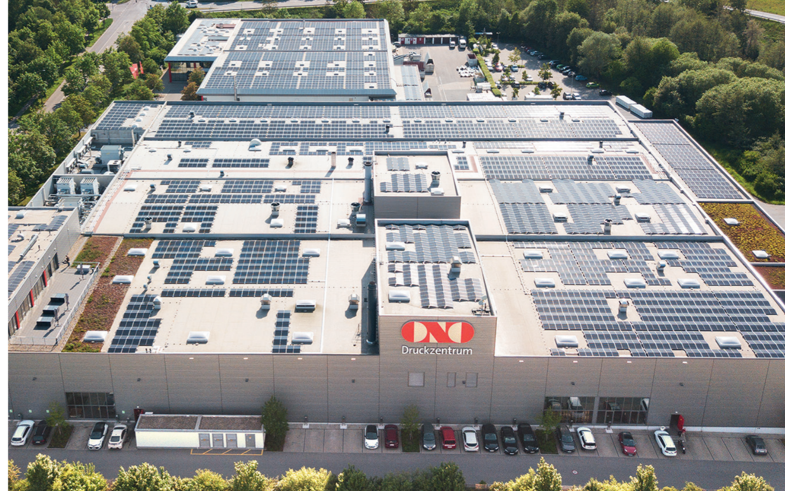
100 % regenerative Energie – das Sonnenkraftwerk aus 5000 Photovoltaik-Modulen
